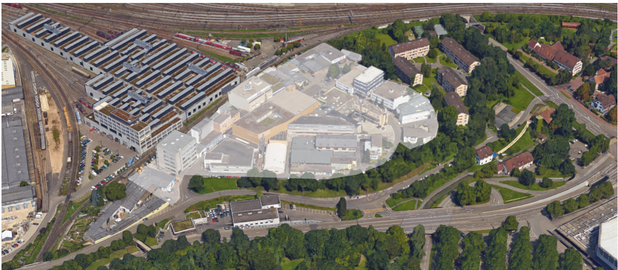
Blick in Richtung Nordwest auf den bestehenden Bebauungsplanperimeter
