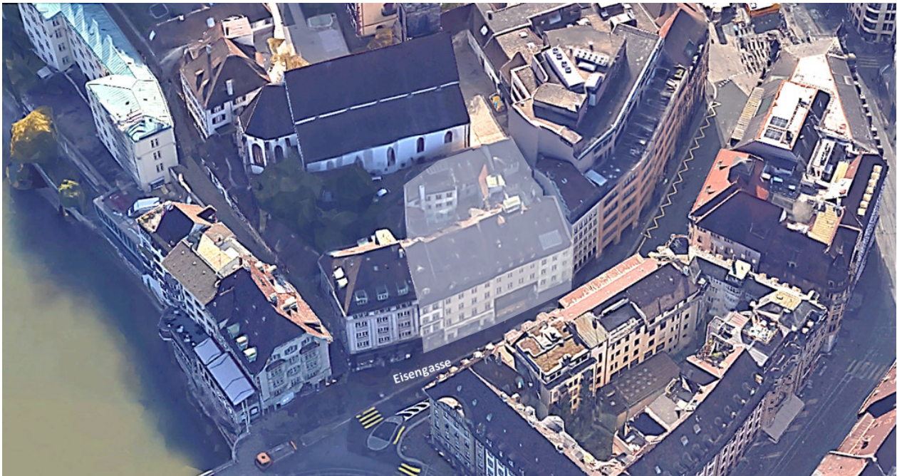
Blick in Richtung Süd auf den Planungsperimeter
