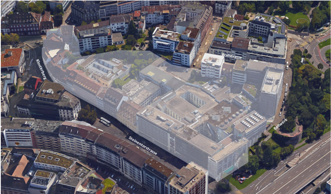
Blick in Richtung Südosten auf den Planungsperimeter
