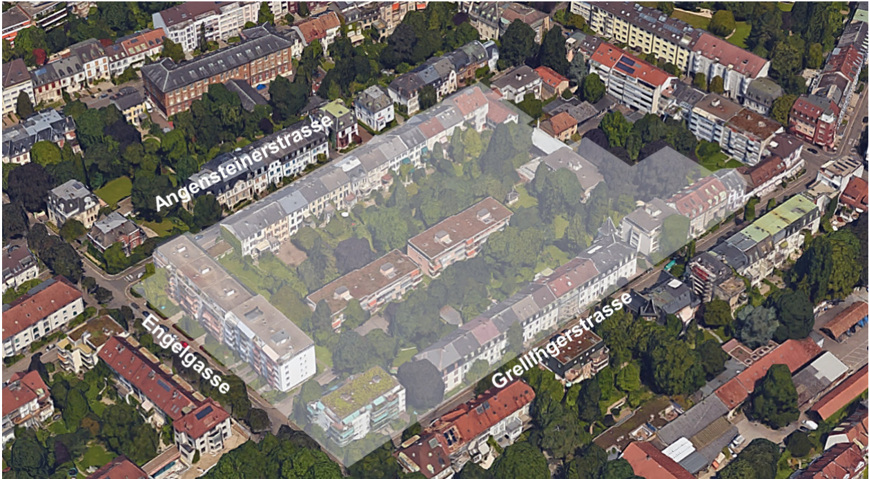
Blick in Richtung Norden auf den Planungsperimeter.
