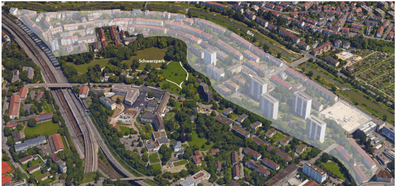
Blick in Richtung Osten auf den Planungsperimeter (Google Maps)
