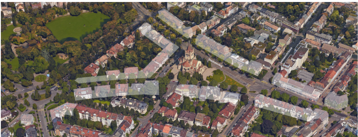
Blick in Richtung Norden auf den Planungsperimeter
