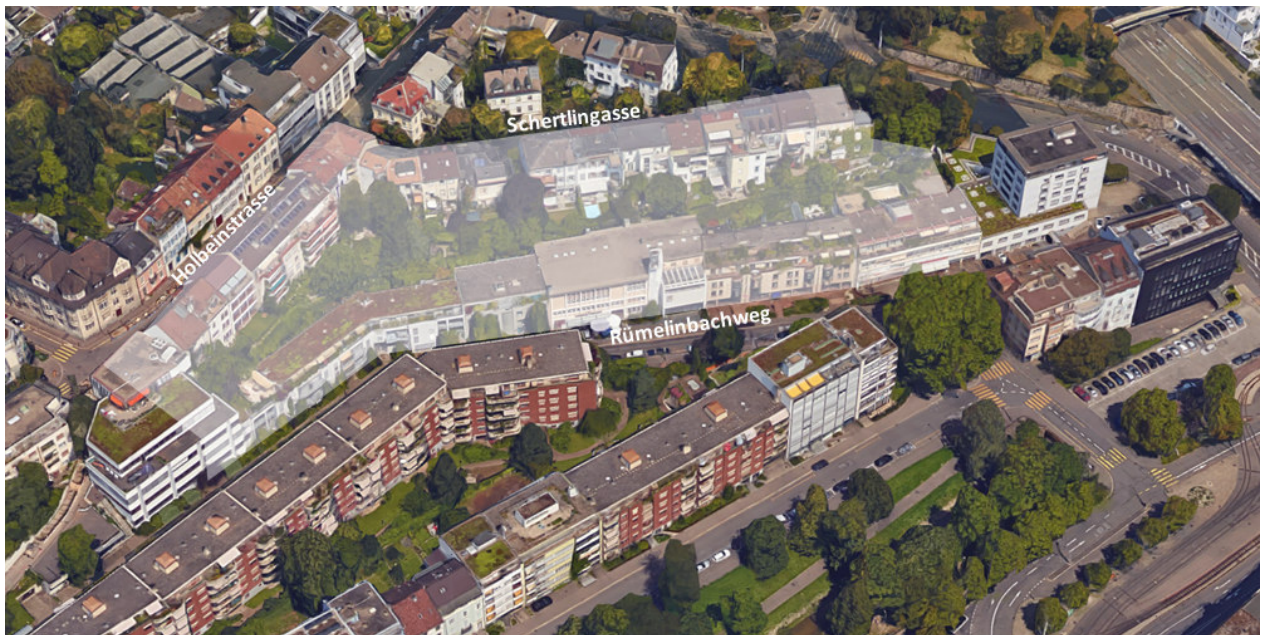
Blick in Richtung Norden auf den Planungsperimeter
