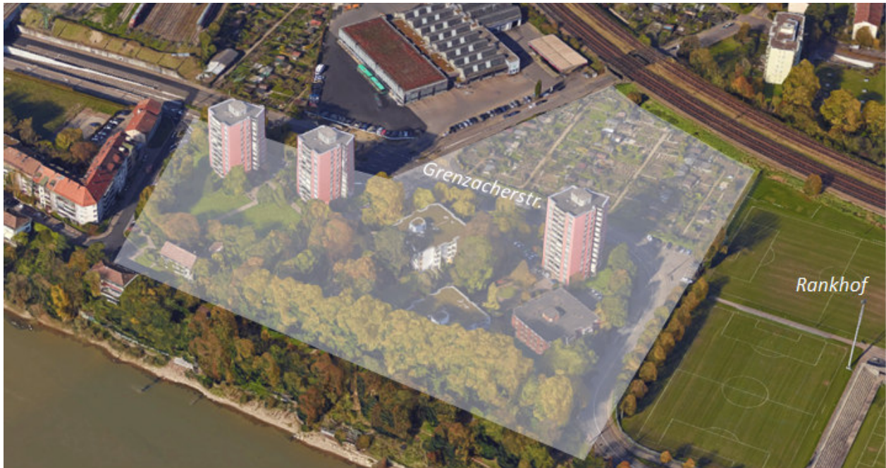
Blick in Richtung Norden auf den Planungsperimeter
