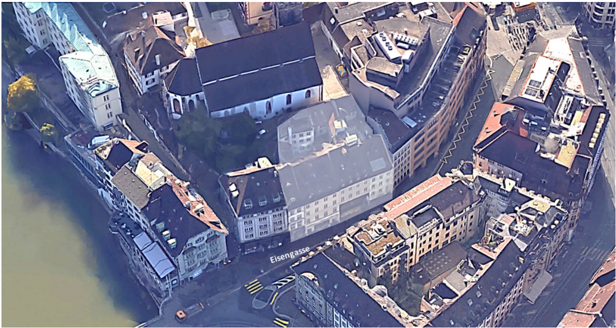
Blick in Richtung Süd auf den Planungsperimeter
