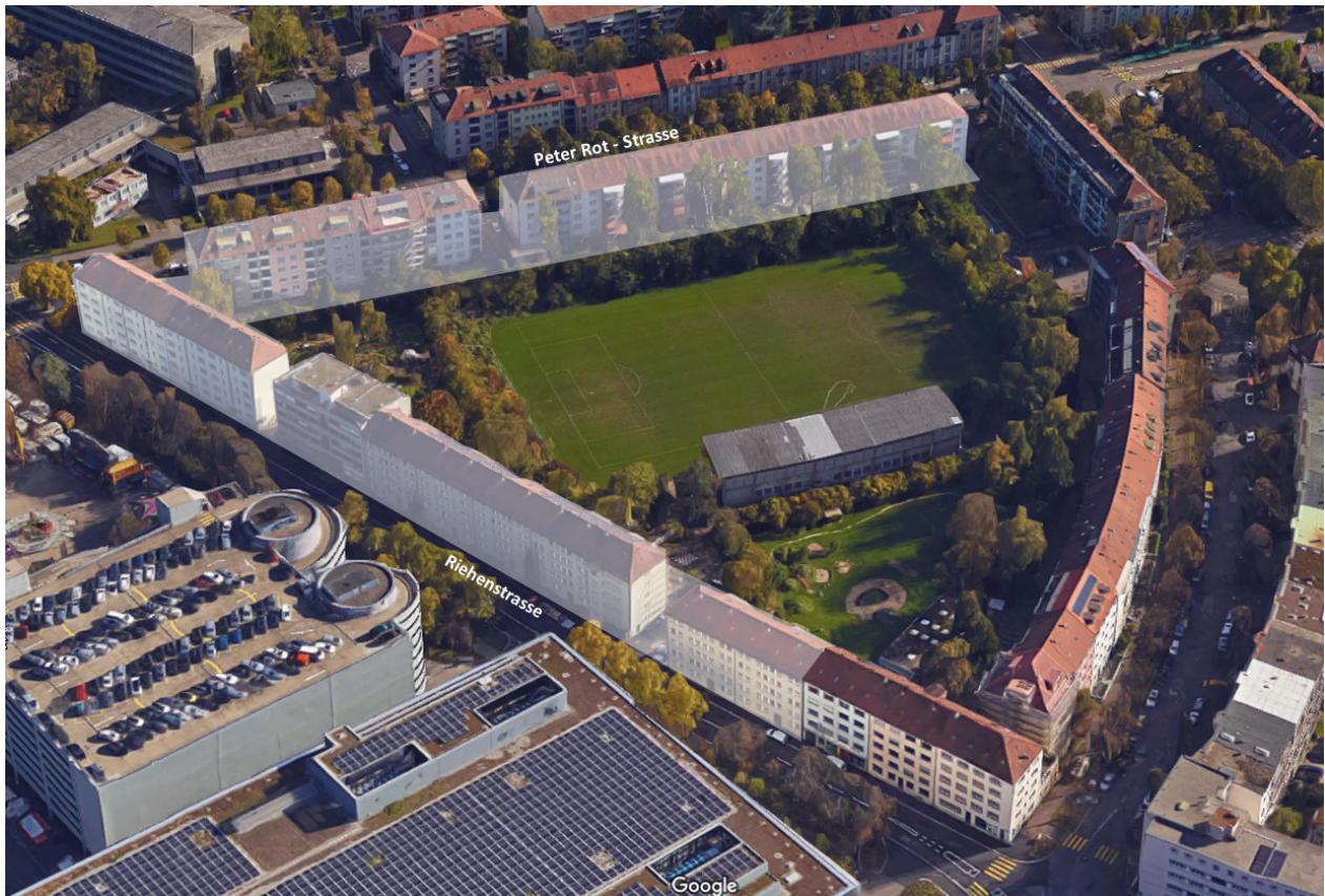
Blick in Richtung Nordosten auf den Planungsperimeter (Google Maps)
