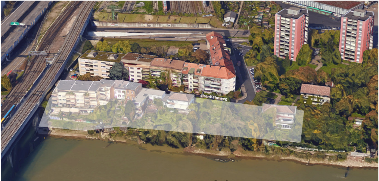
Blick in Richtung Norden auf den Planungsperimeter
