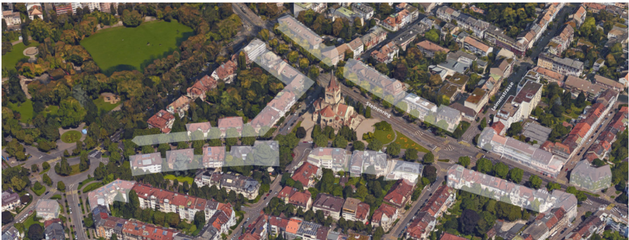
Blick in Richtung Norden auf den Planungsperimeter
