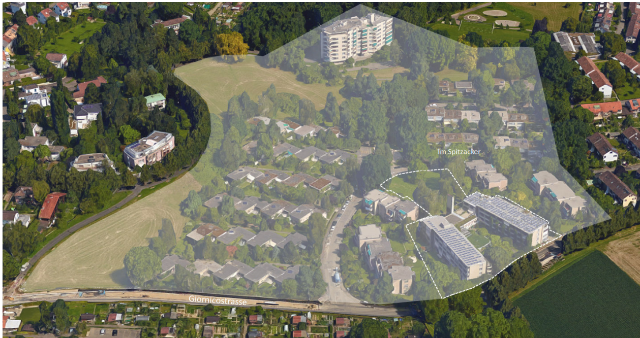
Blick in Richtung Norden auf den Bebauungsplanperimeter (gestrichelte Linie: Vorgeschlagener Bereich für Nutzungen im öffentlichen Interesse)
