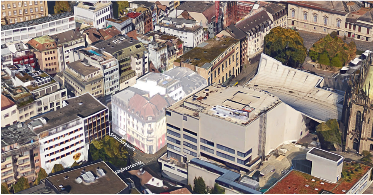
Blick in Richtung Norden auf den Planungsperimeter
