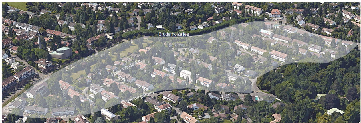
Blick in Richtung Südwest auf den Planungserimeter.
